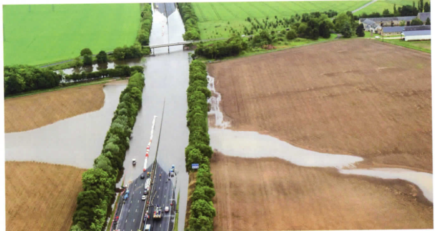
Vue d'avion des inondations.
